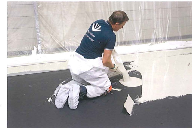
Aufbringen der elektrostatisch ableitfähigen 2K-Beschichtung Sikafloor-3240 ECF.
