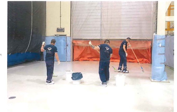
Versiegelung des neuen ESD-Bodensystems im ESTEC mit Sikafloor-305 W ESD. Fotos: Sika Deutschland GmbH
